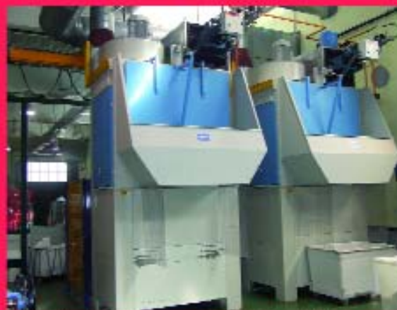
Tunel de lavado de ropa con capacidad para 800 kg/hora
